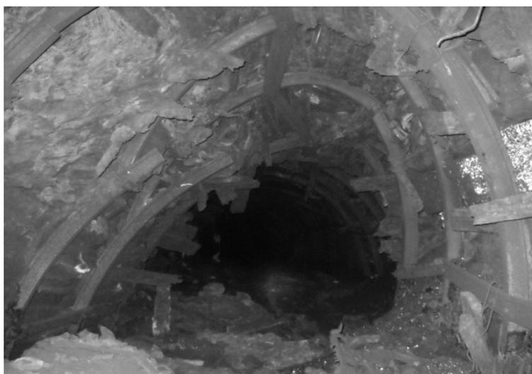
Рис. 5. Состояние 15-го западного откаточного штрека пласта  $h_{10}$  шахты «Партизанская» на участке с показателем устойчивости  $\omega = 0,325$
