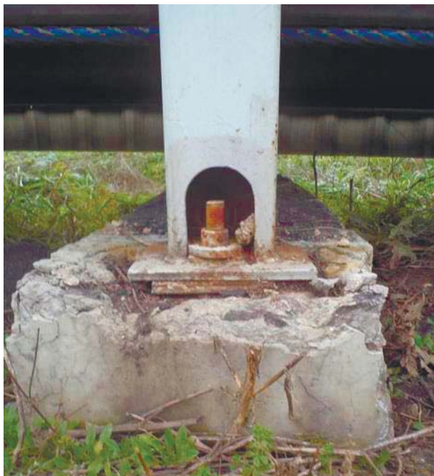
Рис. 3. Частичное разрушение бетона в торцевой части фундамента опоры № 140 (южная сторона)
