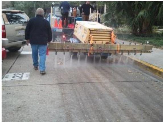
Рис. 2. Применение специального покрытия, содержащего  $TiO_2$  [12]
