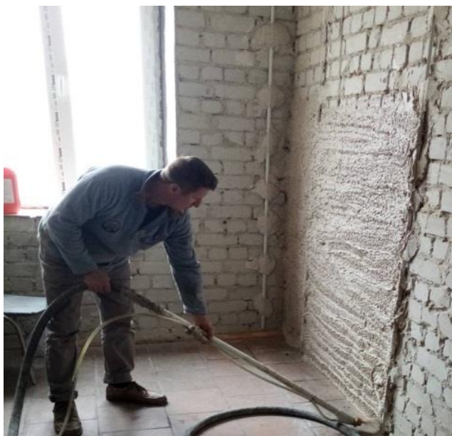
а) процес нанесення гіпсової штукатурки машинним способом;
