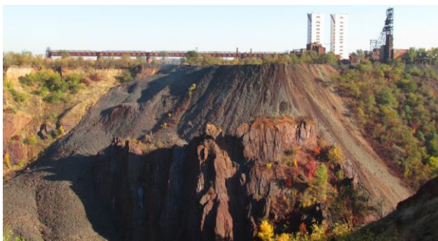
Рис. 7. Засипання провальних зон шахтними породами: (а) – шахта «Козацька»; (б) – шахта «Тернівська» (фото Д. Антонова, Кривий Ріг, 2013 і 2014 роки)
