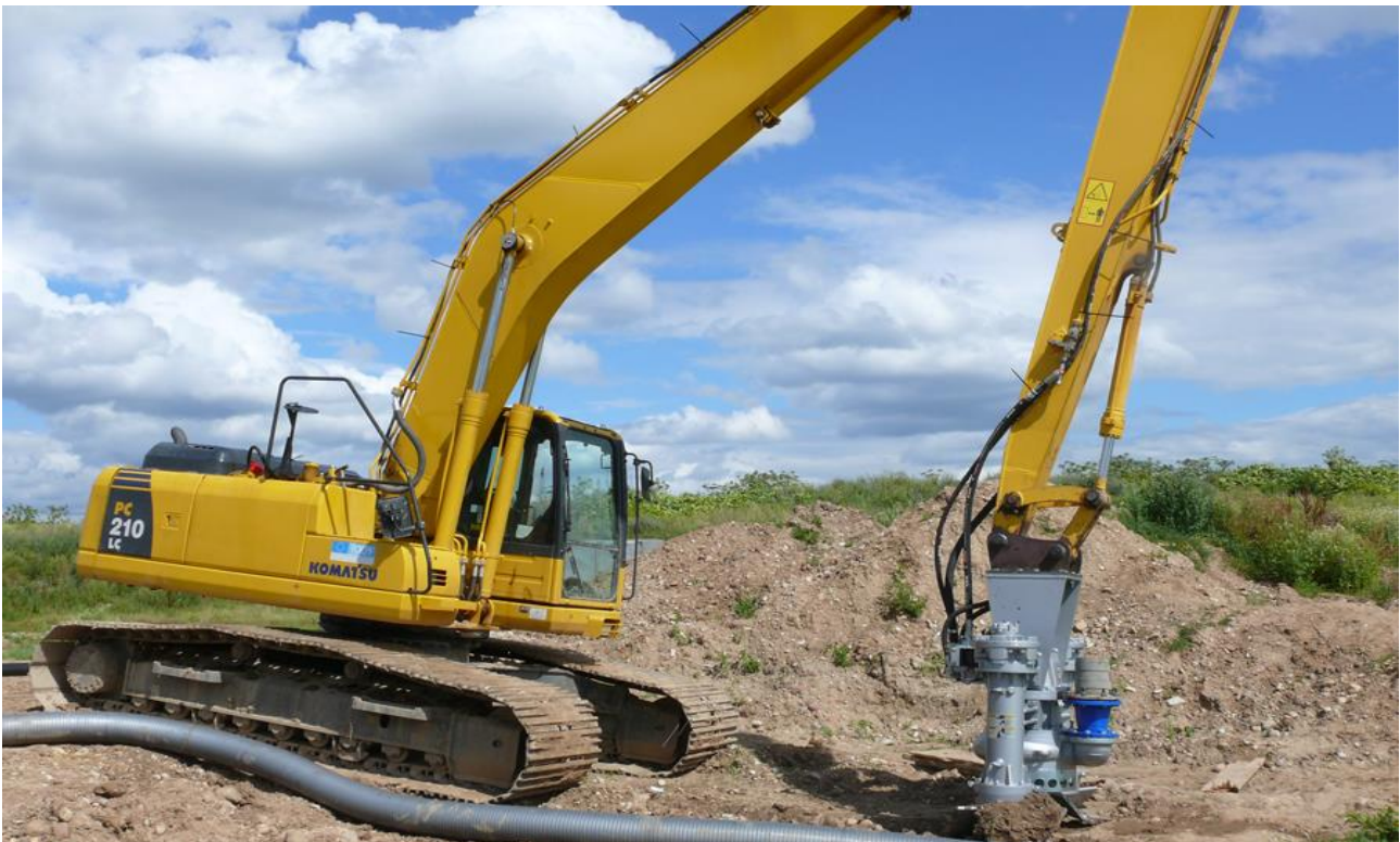
Рис. 5. Екскаватор Komatsu PC 210 LC з землесосом Dragflow HY85 HC
