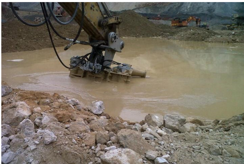
Рис. 3. Приклад застосування ґрунтового насоса на стрілі екскаватора в кар'єрі
