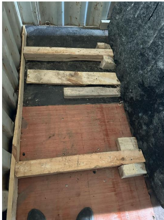
Рис. 5. Схема розміщення розпірок між стінками контейнера та бокової частини блока
