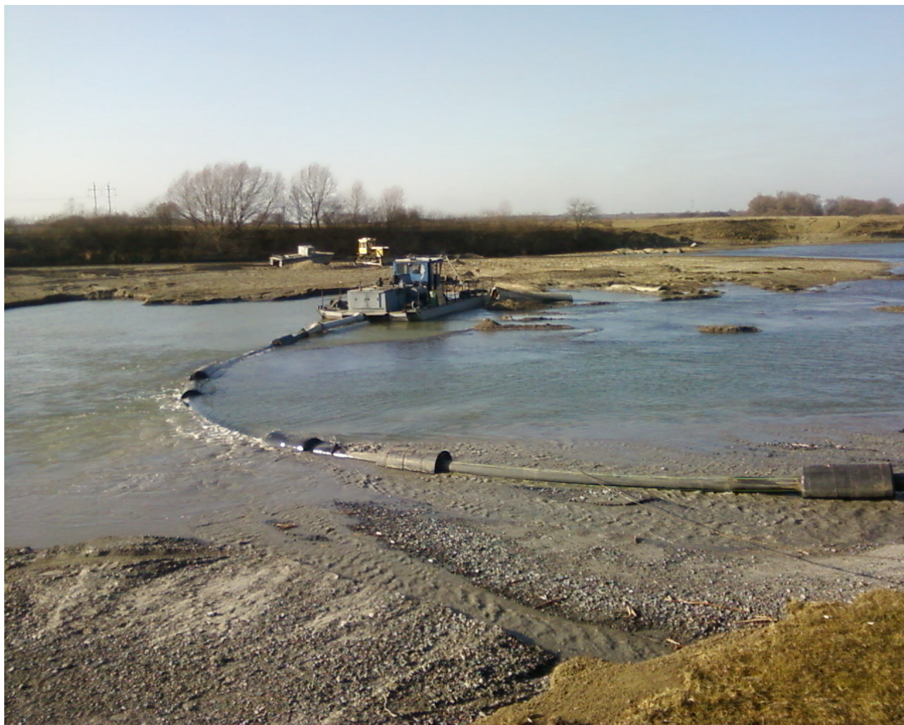
Рис. 4. Ежекторний земснаряд ЗНС 630-90 при виконанні днопоглиблювальних робіт в акваторії р. Тиса
